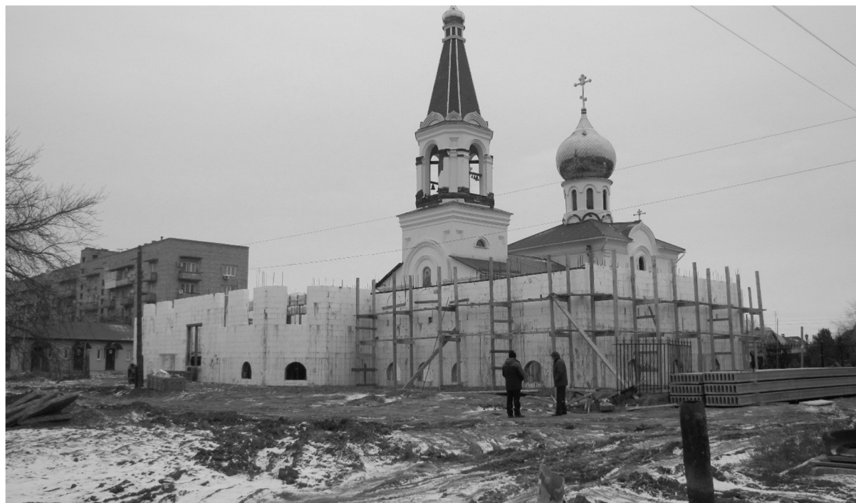
Рис. 7. Строительство духовно-просветительского центра в честь Великого равноапостольного князя Владимира (вид с юго-западной стороны)
