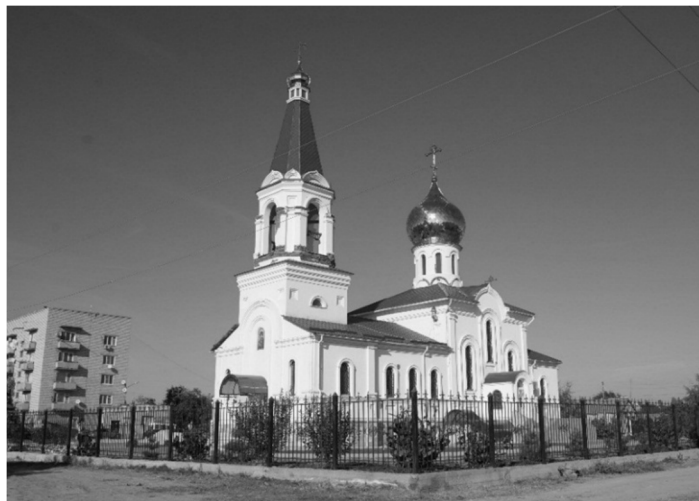
Рис. 1. Здание Храма Владимирской иконы Божией Матери в г. Ахтубинске
