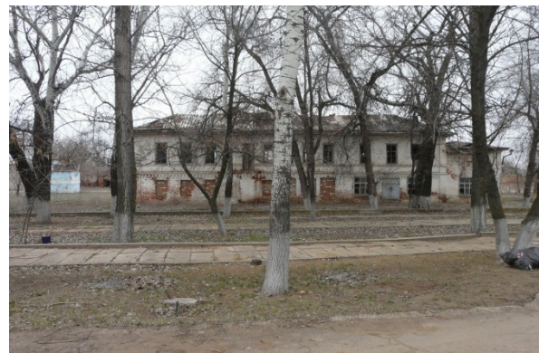
Рис. 7. Трапезный корпус (фото 2016 г.)
