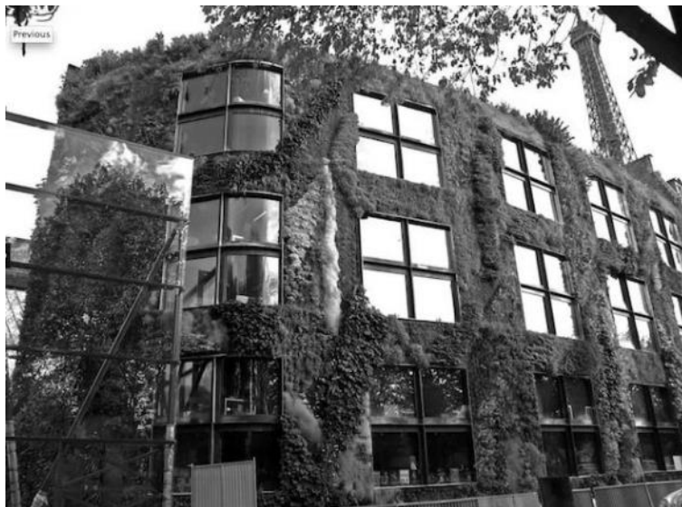
Рис. 4. Пример вертикального озеленения стен здания
