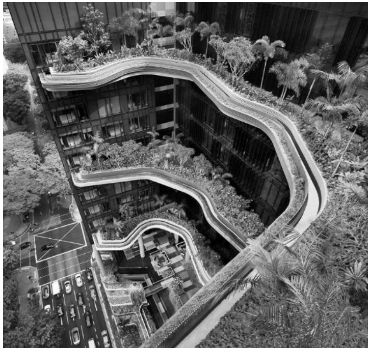
Рис. 7. Пример озеленения кровли многоэтажных зданий (архитектурное бюро WOHA, Сингапур)
