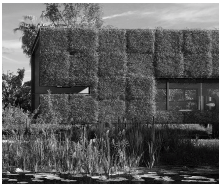
Рис. 5. Озеленение стен фасадов посредством фитомодулей
