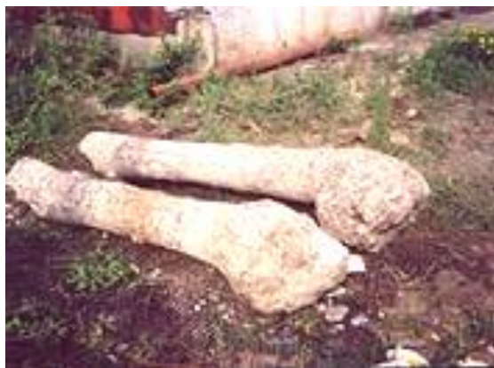
Рис. 10 Иллюстрация буринъекционной сваи с (Джантимиров Х. А., Рытов С. А., 2009г. [27])
