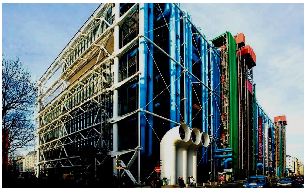
Рис. 3. Коммуникации и технические конструкции центра Помпиду
