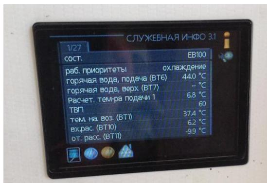
Рис. 3. Обзор оборудования объекта исследования: а) тепловой насос; б) рабочий экран теплового насоса (июнь, 2014 г.)
