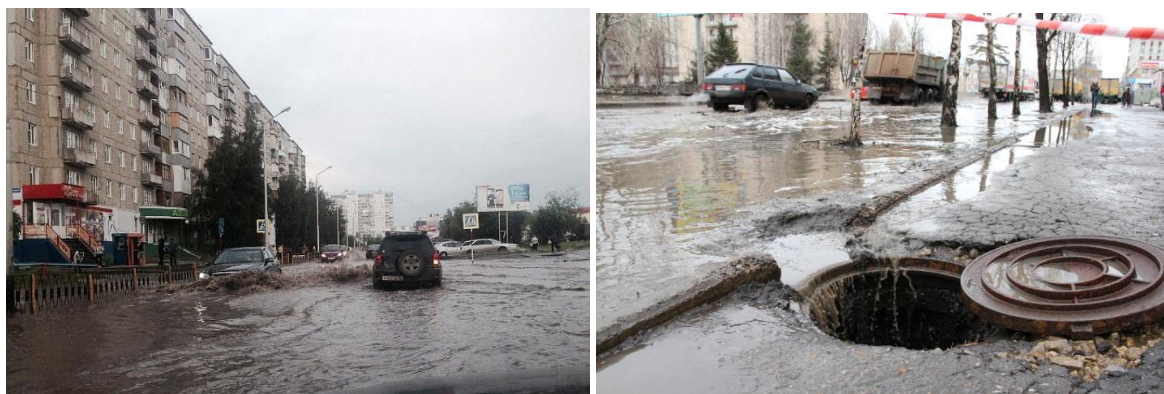
Рис. 3. Несанкционированное поступление ливневого стока с дорожной поверхности в систему хозяйственно-бытового водоотведения, в условиях отсутствия функционирующей ливневой канализации
