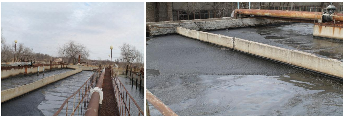
Рис. 2. Несанкционированное поступление нефтешламовых отходов на очистные сооружения канализации
