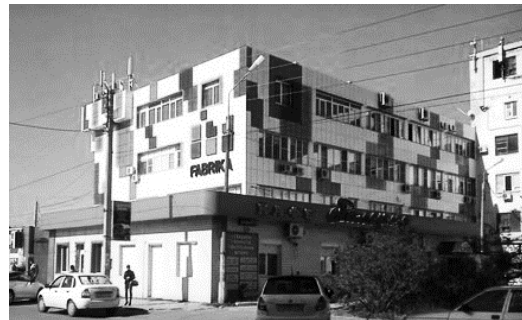
Реконструкция бывшей балониевой фабрики под бизнес-центр «Технопарк Fabrika», г. Астрахань
