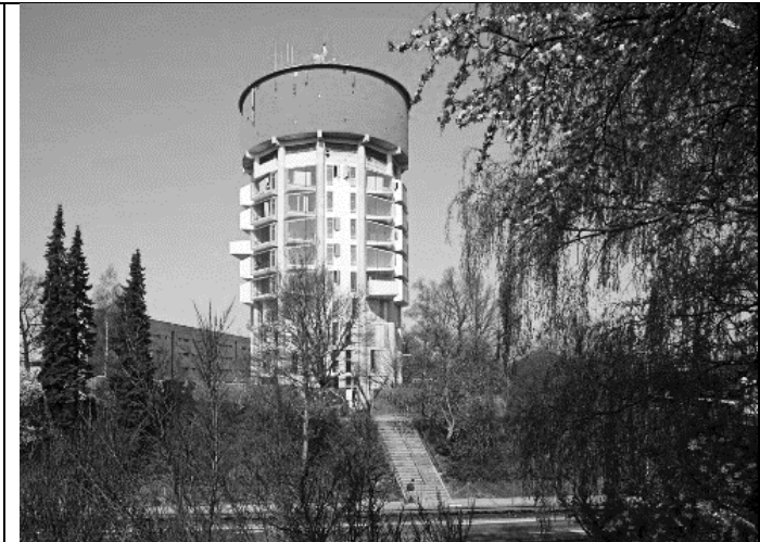
JaegersborgWaterTower - студенческое общежитие в старой водонапорной башне, г.Гентофте, Дания
