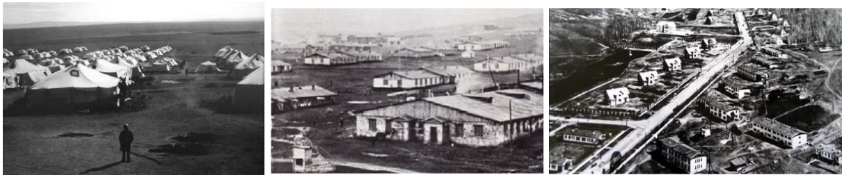
Рис. 1. Расселение строителей: а, б – рабочих в брезентовые палатки и бараки, в – руководящий состав в секционные дома.
