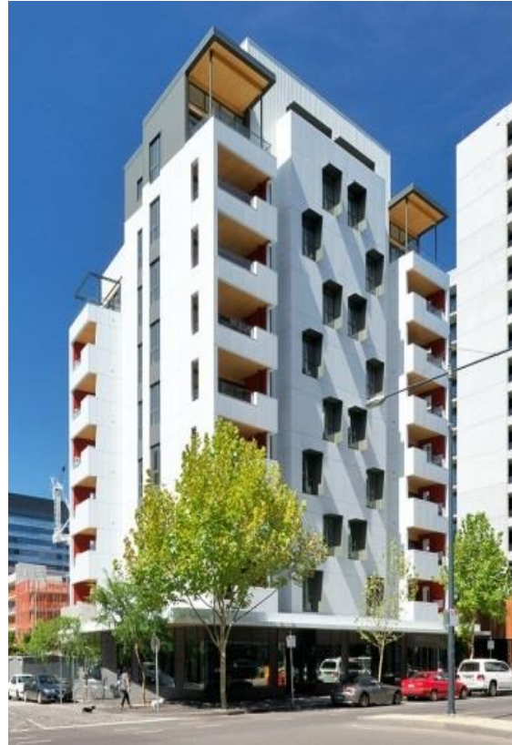
Рис. 4. Многоэтажный деревянный жилой комплекс Forte в Мельбурне
