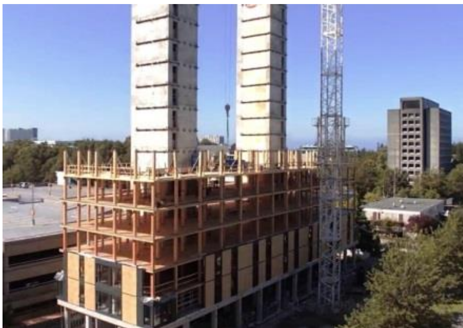
Рис. 7. Пример многоэтажных домов из дерева
