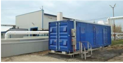
Рис. 5. Приемная и распределительная камеры БОСК г. Казань. Установка НПО ЛИТ. Производительность: 5 000 м 3 /ч. Вход: С H2S = 10-100 мг/м 3 . Выход: С H2S ≤ 0,1 мг/м 3
