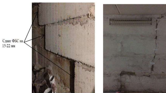
Рис. 7. Фотофиксация – сдвиг фундаментных блоков в подвале пристроя (слева на фото) и их разрыв (фото справа)
