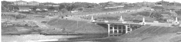
Рис. 1. Архивная фотография Астраханского моста
