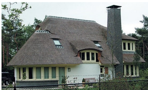
Рис.1. Камышитовая кровля на жилом доме
