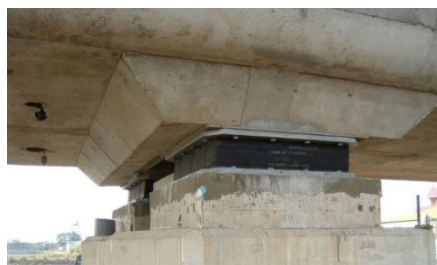
Рис. 1. Использование демпферов в мостовых сооружениях
