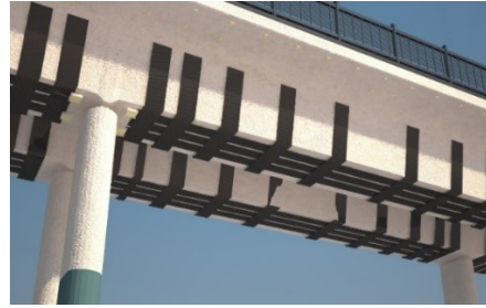
Рис. 4. Укрепление моста композитными материалами
