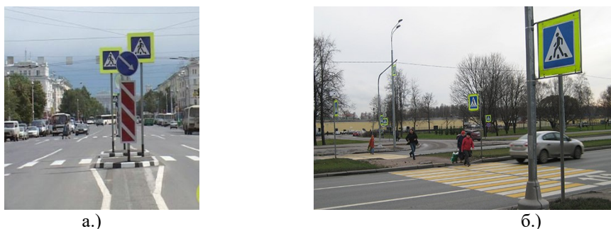
Рис. 2. Устройство пешеходных переходов в России а.) нерегулируемый пешеходный переход с «островком безопасности»; б.) пример пешеходного перехода на проспекте Непокорённых в Санкт-Петербурге
