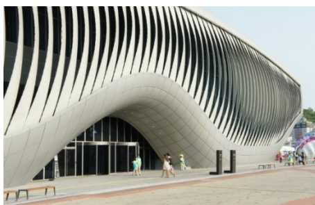
Рис. 3. Выставочный павильон OneOcean в Южной Корее (фрагмент фасада)
