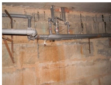
Рис. 3. Присоединение стояков
