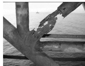
Рис. 1. Сквозная коррозия и каверны на элементе морской платформы
