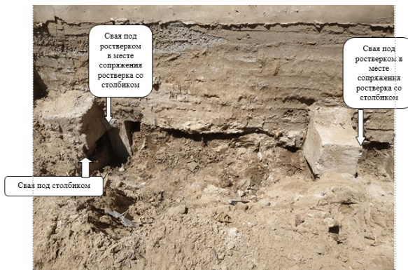
Фото 1. Столбики в нижней части ростверка в осях А2 и А3
