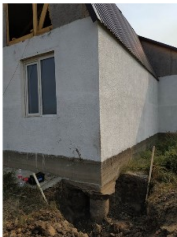
Фото 6. Оголённое тело буронабивной сваи в шурфе под одноэтажный жилой дом
