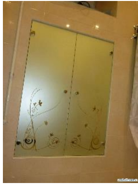
Рис. 8. Настенный светильник с лампой, зеркальными изнутри створками и листовым люминофором
