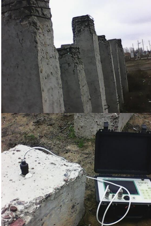
Рис. 7. Фотографии с экспериментной площадки объекта незавершенного строительства по оценке состояния свай спектрально-временным анализом
