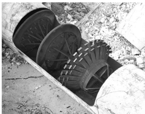
Рис. 5. Иллюстрация одного из типов механического скребка с резиновым диском для удаления отделившихся от стенки трубы загрязнений
