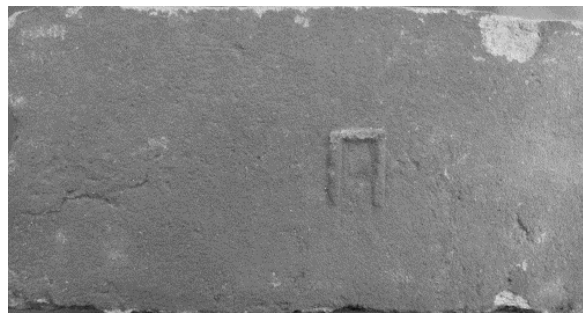
Рис. 6. Кирпич с клеймом завода-изготовителя на постельной грани
