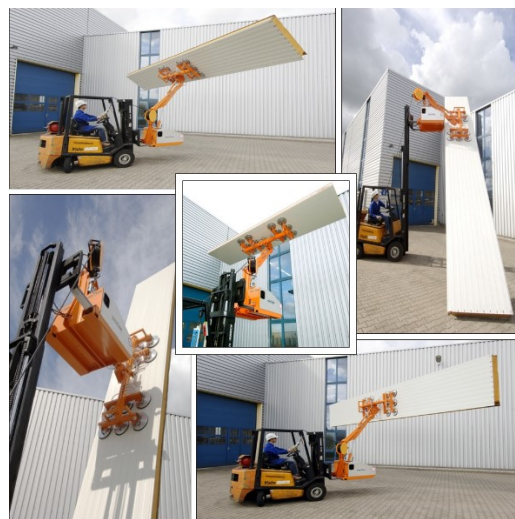
Рис. 8. Вакуумное оборудование для монтажа сэндвич-панелей
