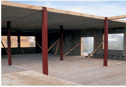
Рис. 1. Быстровозводимая строительная система «Модуль» в процессе монтажа [3]
