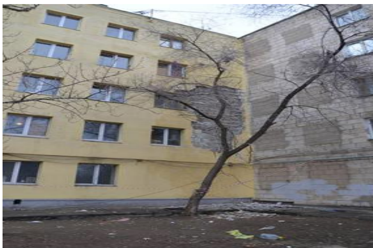
Рис. 8. Отслоения отделочных слоев
