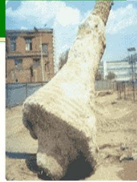
Общий вид буронабивной свай с уширением в форме полусферы, образованным разбуhrиванием грунта расширителем (1964г.)
