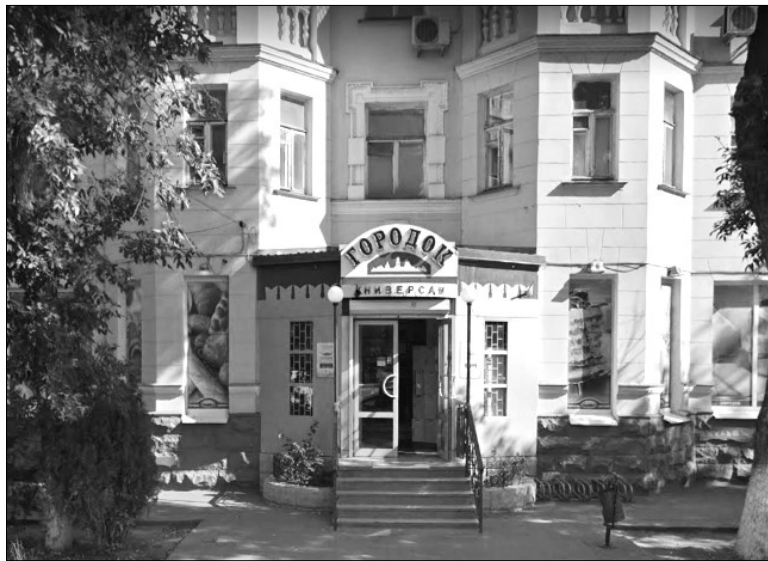
Рис. 6. Ул. Адмиралтейская, 8, г. Астрахань. Жилой дом с магазинами «Бакалея» и «Гастрономия» для речников «Волготанкера» из ансамбля жилых и административных домов с Площадью им. Ленина. Построен в 1958 г.
