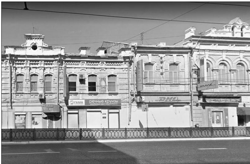
Рис. 4. Ул. Адмиралтейская, г. Астрахань
