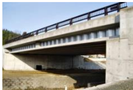
Рис. 1. Мосты с применением гофробалок
