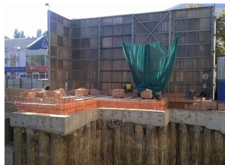
Рис. 2. Процесс реконструкции здания
