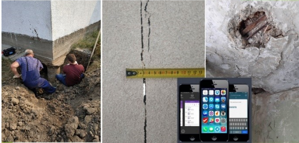
Рис. 1. Фотофиксация проведения экспертных строительных работ
