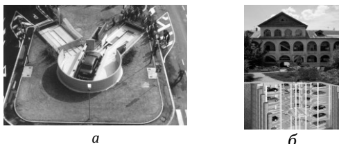
Рис. 3. а) общий вид автоматизированного паркинга TREVIPARK на уровне земли; б) общая схема размещения автомобилей в автоматизированной парковке при плотной застройке
