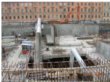
Рис. 5. Проем в монолитном железобетонном перекрытии при строительстве второй сцены Мариинского театра с устройством методом «сверху – вниз» глубокого котлована, огражденного монолитной стеной в грунте [12]
