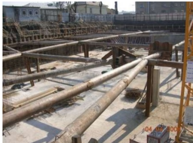
Рис. 4. Распорная система крепления стен котлована при выемке грунта открытым способом в пространстве, ограниченном стеной в грунте [12]
