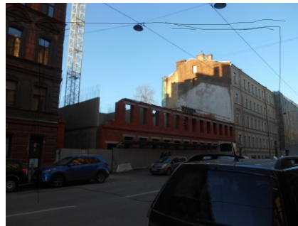
Рис. 1. Строительство монолитного здания с кирпичным фасадом при реконструкции табачной фабрики в исторической части Санкт-Петербурга (ул. Бронницкая, 11). Фотография Ю. И. Тилинина
