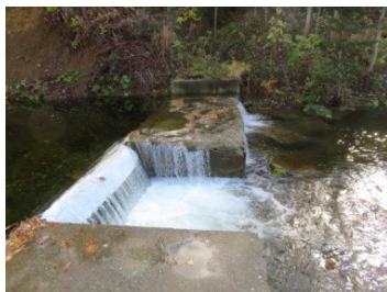
Рис. 1. Пример карбонизации и выщелачивания бетона гидротехнической конструкции
