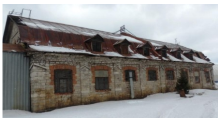
Рис. 2. Внешний вид здания, расположенного на территории бывшего завода им. А.А. Шпагина
