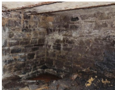
Рис. 3. Фундамент здания из блоков природного камня
