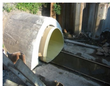
Рис. 2. Санация шатрового трубопровода из стеклопластика
