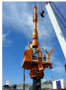
Рис. 2. Установка BUMA для бурения с эрлифтом в погруженной обсадной трубе ( https://koper.pro/drilling-rig-rcd/ (20.07.2023 г.))
