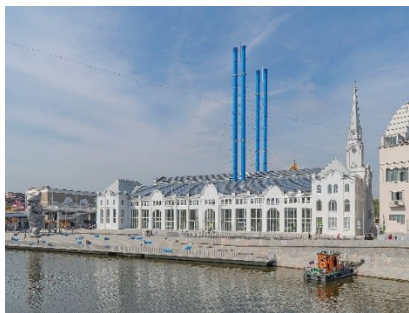
Рис. 6. Вид сбоку на Электростанция «ГЭС-2»
