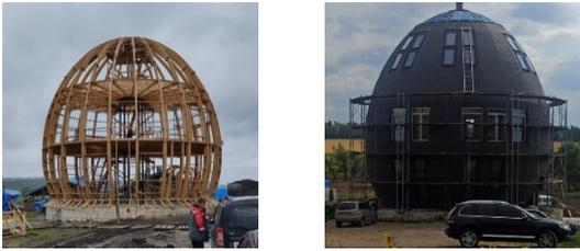
Рис. 3. Эллипсоидный частный дом на этапе возведения каркаса
