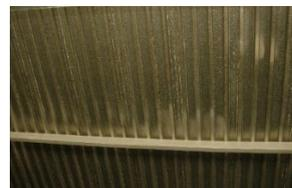
Рис. 5. Состояние оцинкованного профилированного настила покрытия, эксплуатирующего в газовойдушной среде, которая не содержит хлороводород
