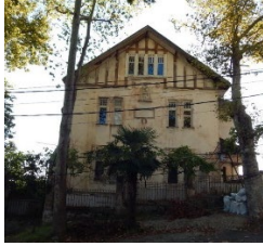
Рис. 16. Здание станции Индо-Европейского телеграфа, ул. Чочуа, 45, г. Сухум
