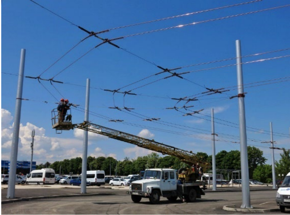
Рис. 1. Монтаж простой подвески на разворотном кольце троллейбуса
