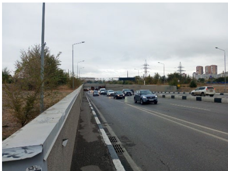
Рис. 5. Тоннель для защиты от шума
