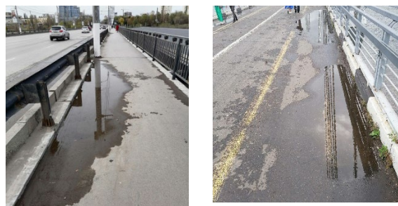
Рис. 4. Дождевая вода на тротуаре моста: а – мост через реку Царицу в Волгограде; б – нет водоотвода с тротуара моста в Красноярске (иллюстрация авторов) Fig. 4. Rainwater on the sidewalk of the bridge: а – bridge over the Tsarina River in Volgograd; б – there is no drainage from the sidewalk of the bridge in Krasnoyarsk (illustration by the authors)
