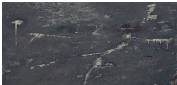
Рис. 3. Наросты-сталактиты на плите проезжей части (иллюстрация авторов) Fig. 3. Growths-stalactites on the roadway slab (illustration by the authors)
