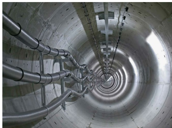
Рис. 1. Коммуникационный тоннель круглого сечения
